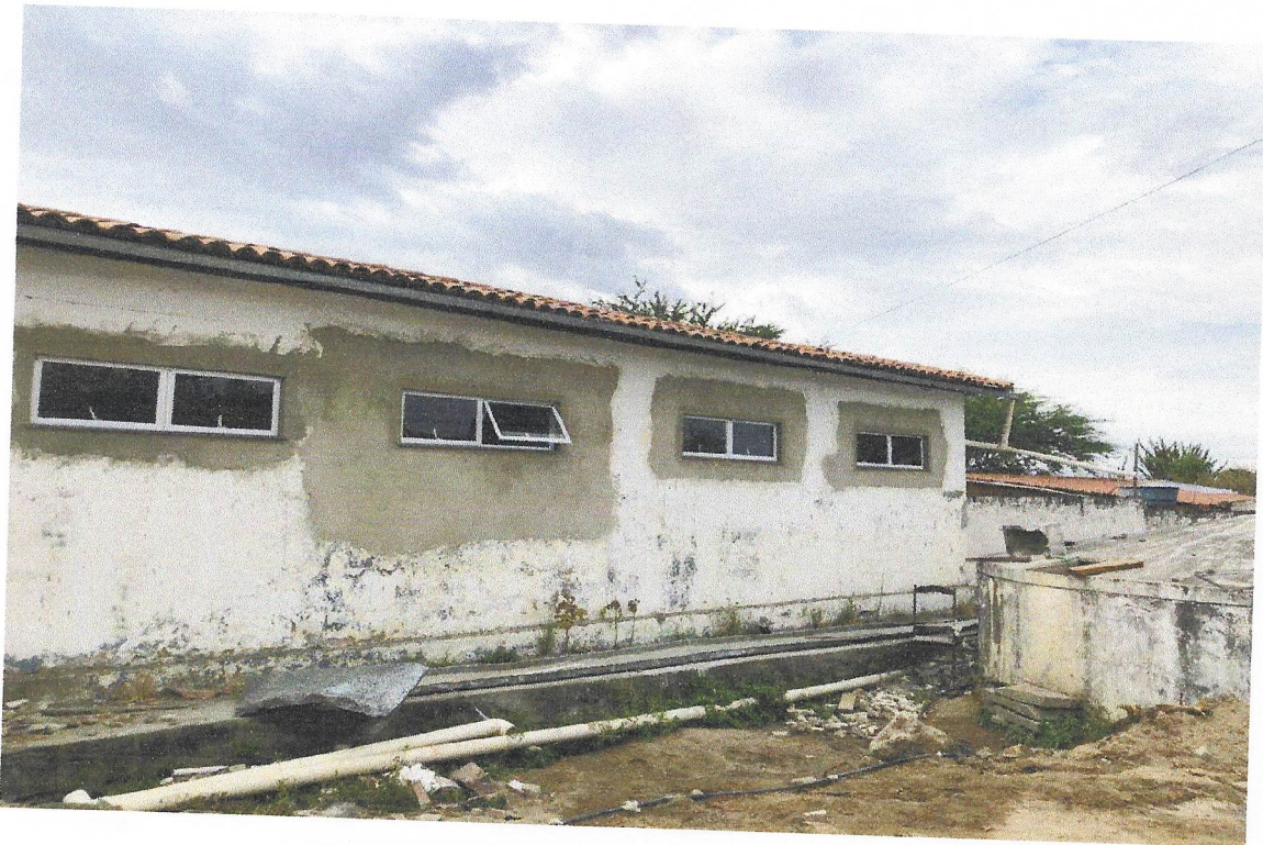
FOTO 09 INSTALAÇÃO DE ESQUADRIAS DE ALUMINIO
