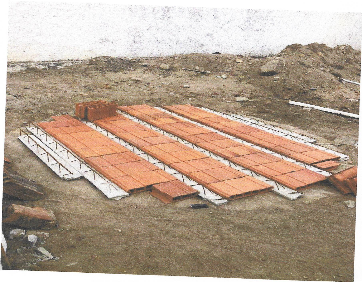
FOTO 05 EXECUÇÃO DE FILTRO E SUMIDOURO
