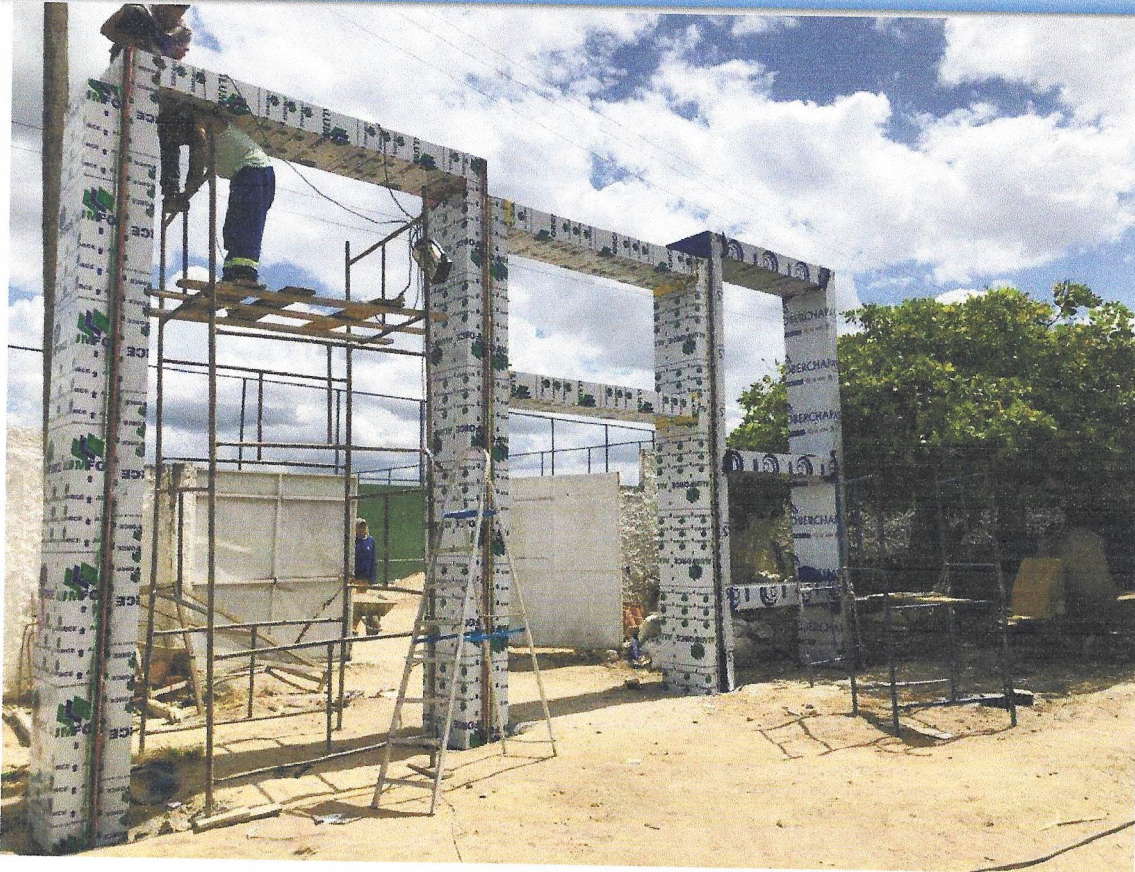
FOTO 01 EXECUÇÃO DE PORTAL REVESTIDO EM ACM
