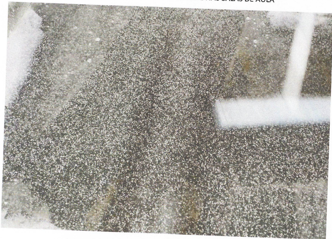
FOTO 18 EXECUÇÃO DE PISO GRANILITE NAS SALAS DE AULA
