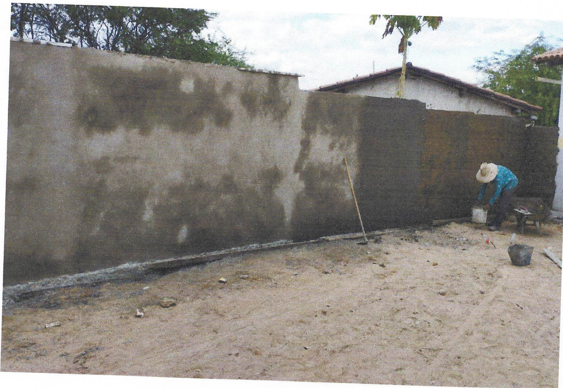
FOTO 07 EXECUÇÃO DE REBOCO EXTERNO
