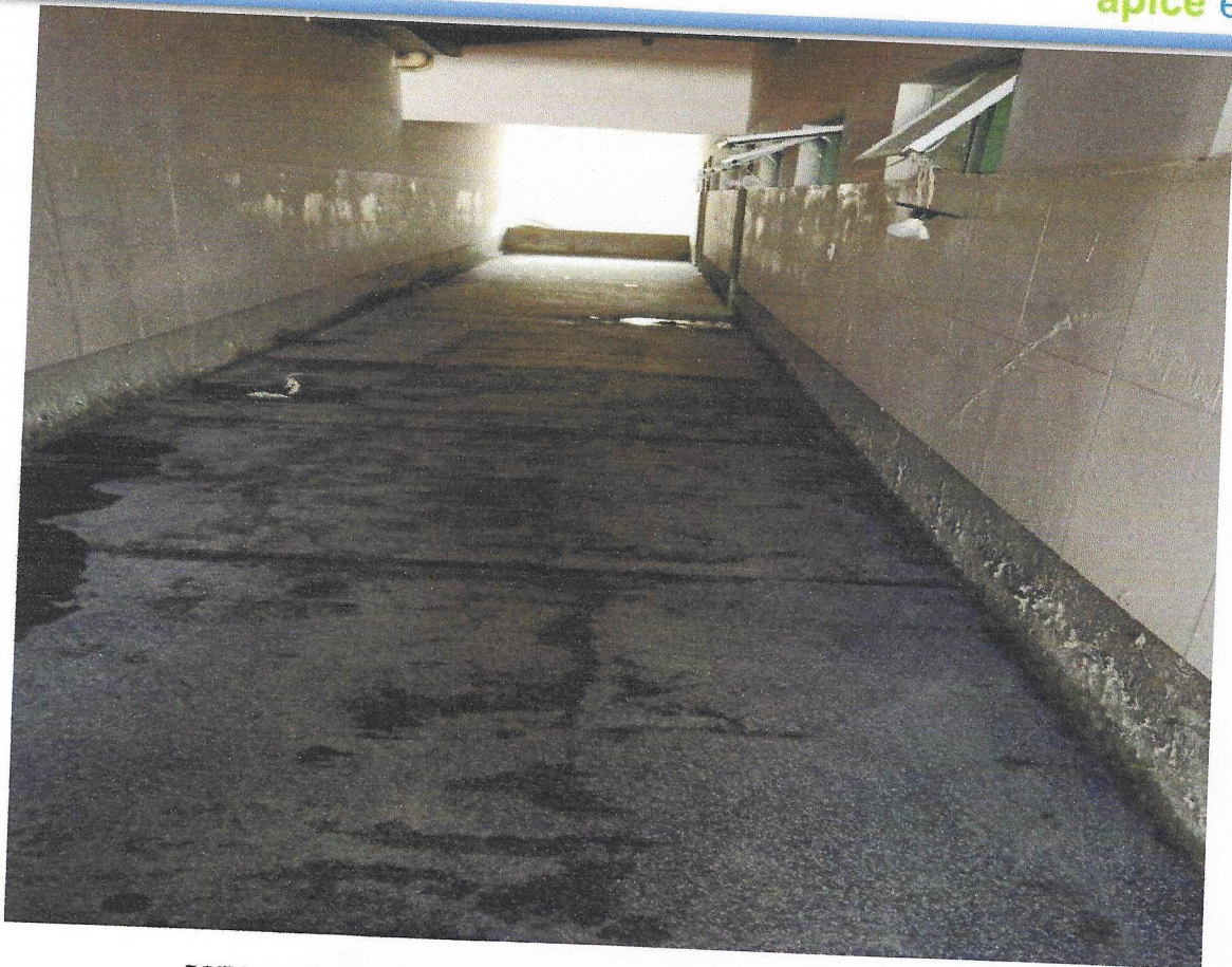
FOTO 21 EXECUÇÃO DE PISO GRANILITE NO CORREDOR PRINCIPAL
