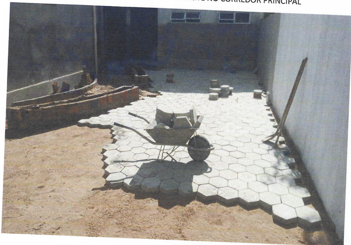
FOTO 22 EXECUÇÃO DE PISO INTERTRAVADO NO PATIO DA ESCOLA
