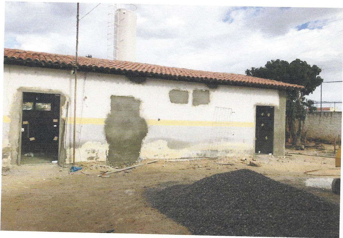
FOTO 15 INSTALAÇÃO DE PORTAS DE VIDROS NA AREA EXTERNA
