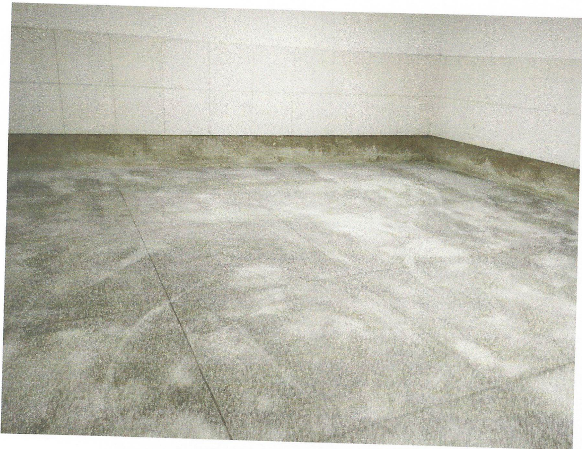
FOTO 19 EXECUÇÃO DE PISO GRANILITE NAS SALAS DE AULA
