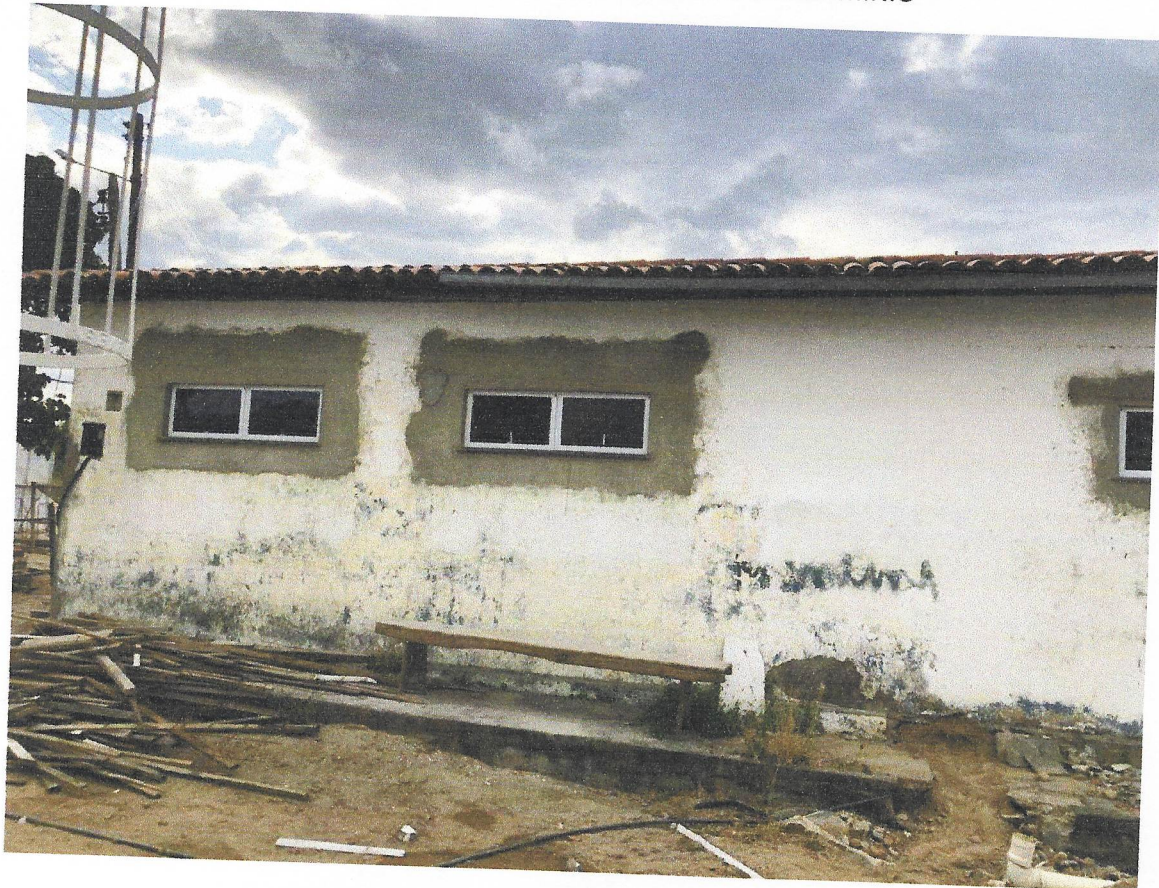
FOTO 10 INSTALAÇÃO DE ESQUADRIAS DE ALUMINIO
