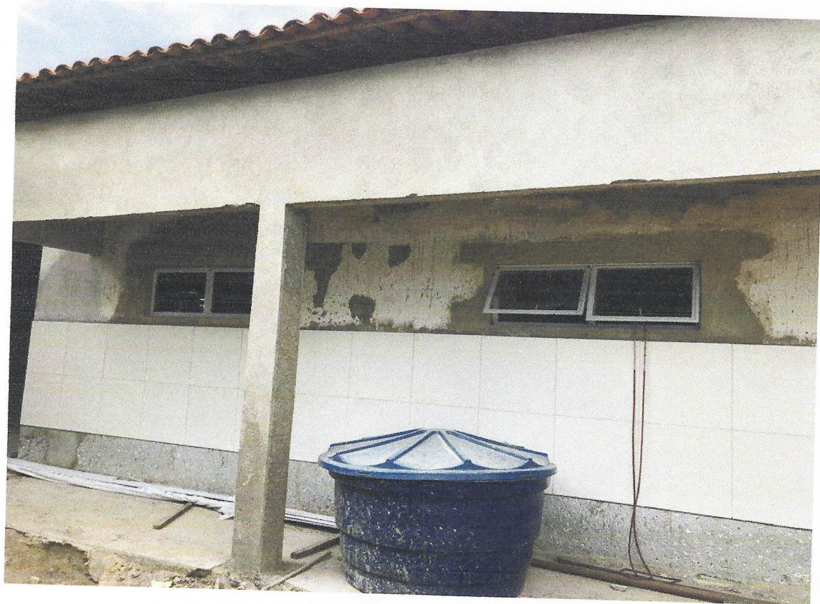
FOTO 12 INSTALAÇÃO DE ESQUADRIAS DE ALUMINIO
