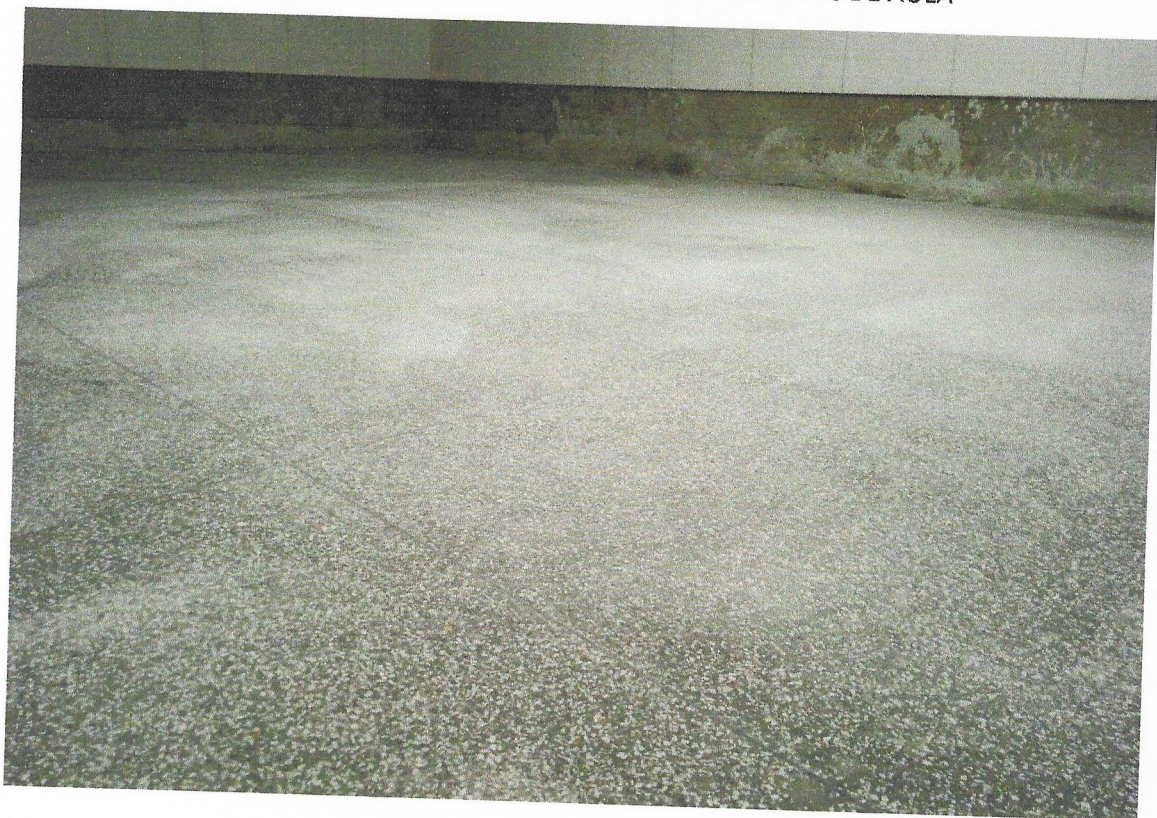
FOTO 20 EXECUÇÃO DE PISO GRANILITE NAS SALAS DE AULA
