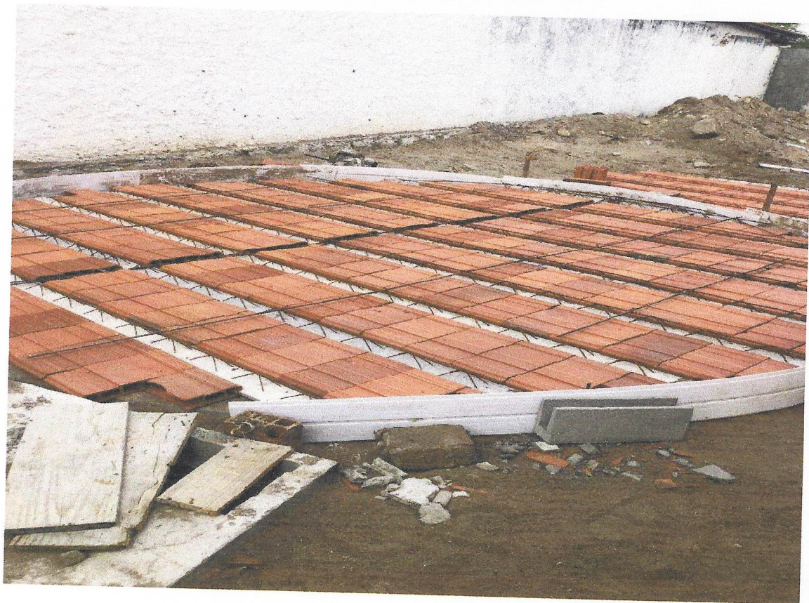
FOTO 04 EXECUÇÃO DE FILTRO E SUMIDOURO
