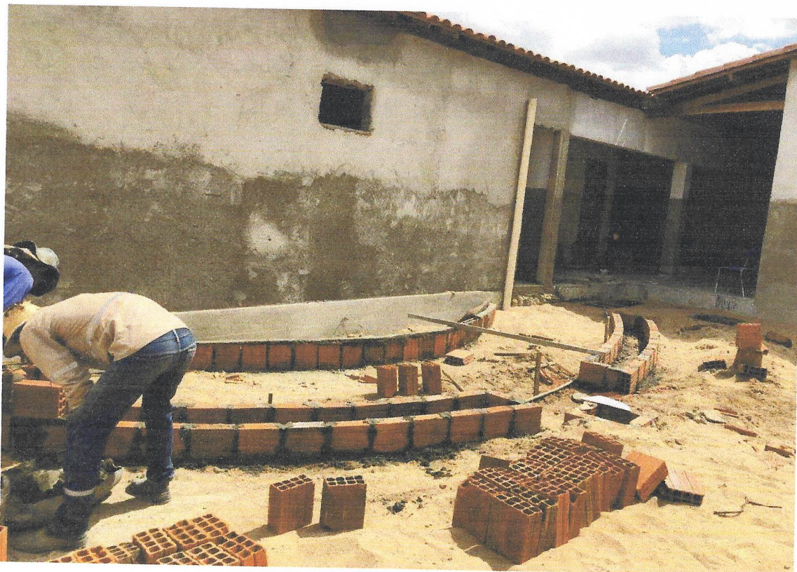
FOTO 02 EXECUÇÃO DOS CANTEIROS
