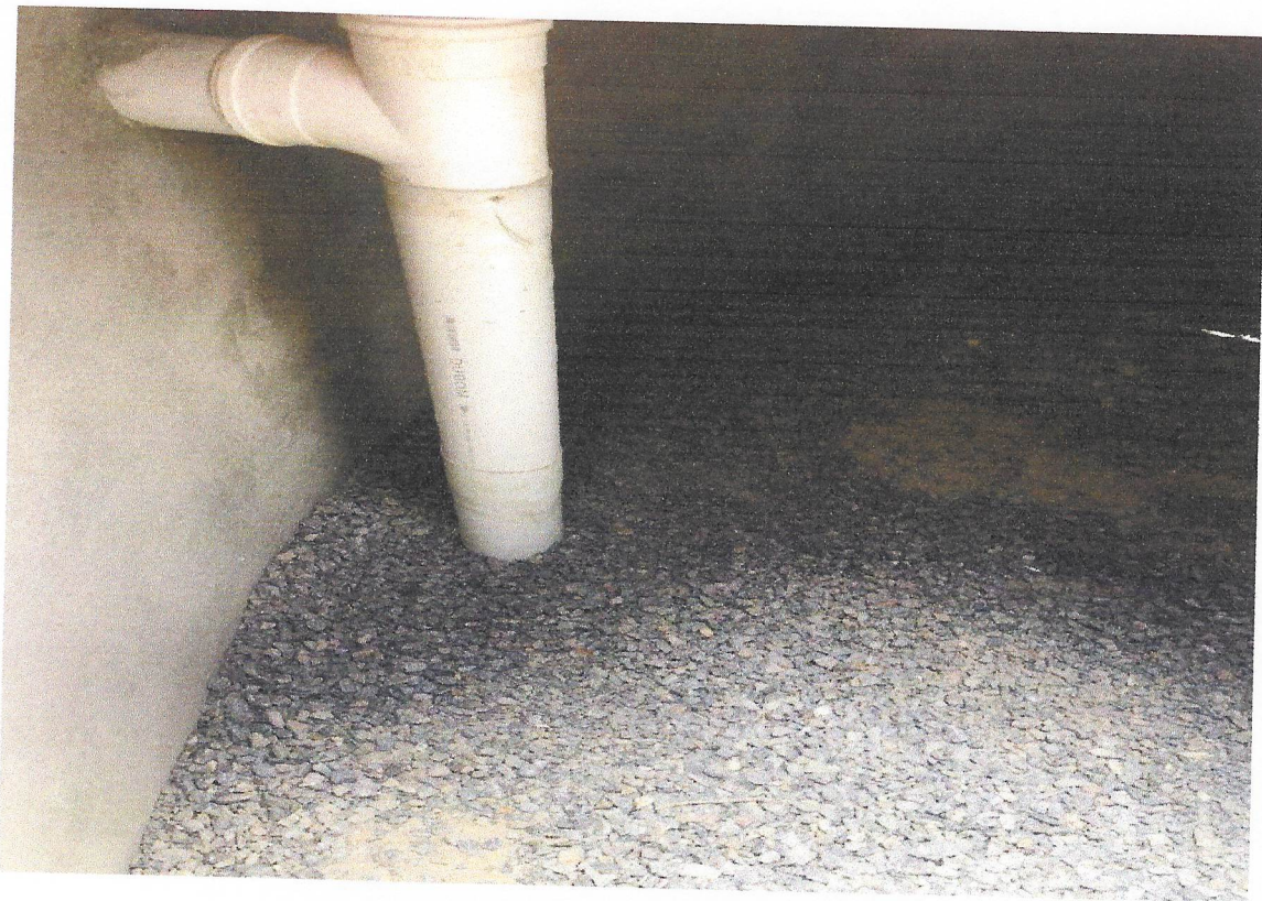
FOTO 03 EXECUÇÃO DE FILTRO E SUMIDOURO
