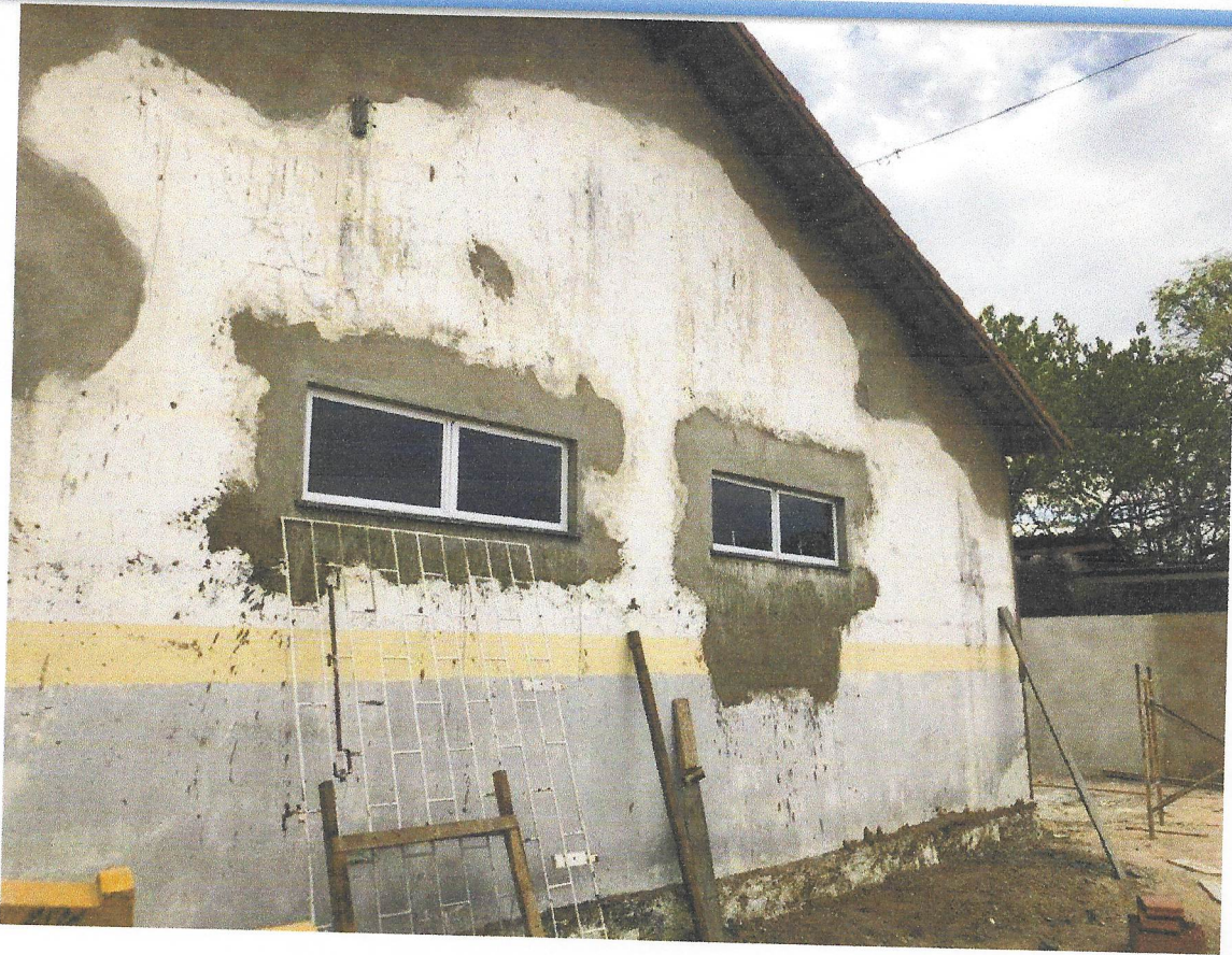
FOTO 11 INSTALAÇÃO DE ESQUADRIAS DE ALUMINIO
