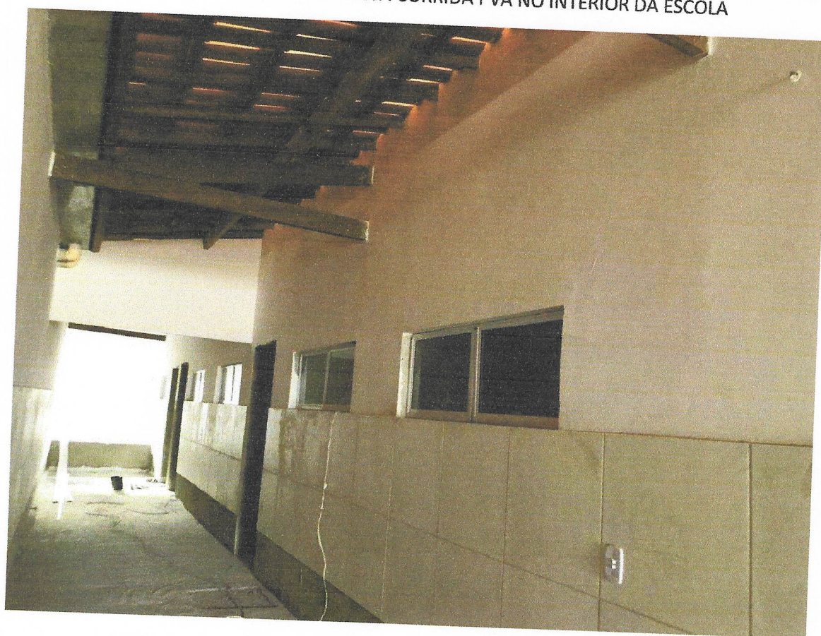
FOTO 14 EXECUÇÃO DE MASSA CORRIDA PVA NO INTERIOR DA ESCOLA
