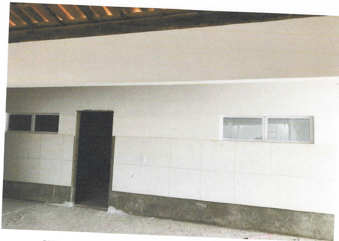
FOTO 13 EXECUÇÃO DE MASSA CORRIDA PVA NO INTERIOR DA ESCOLA
