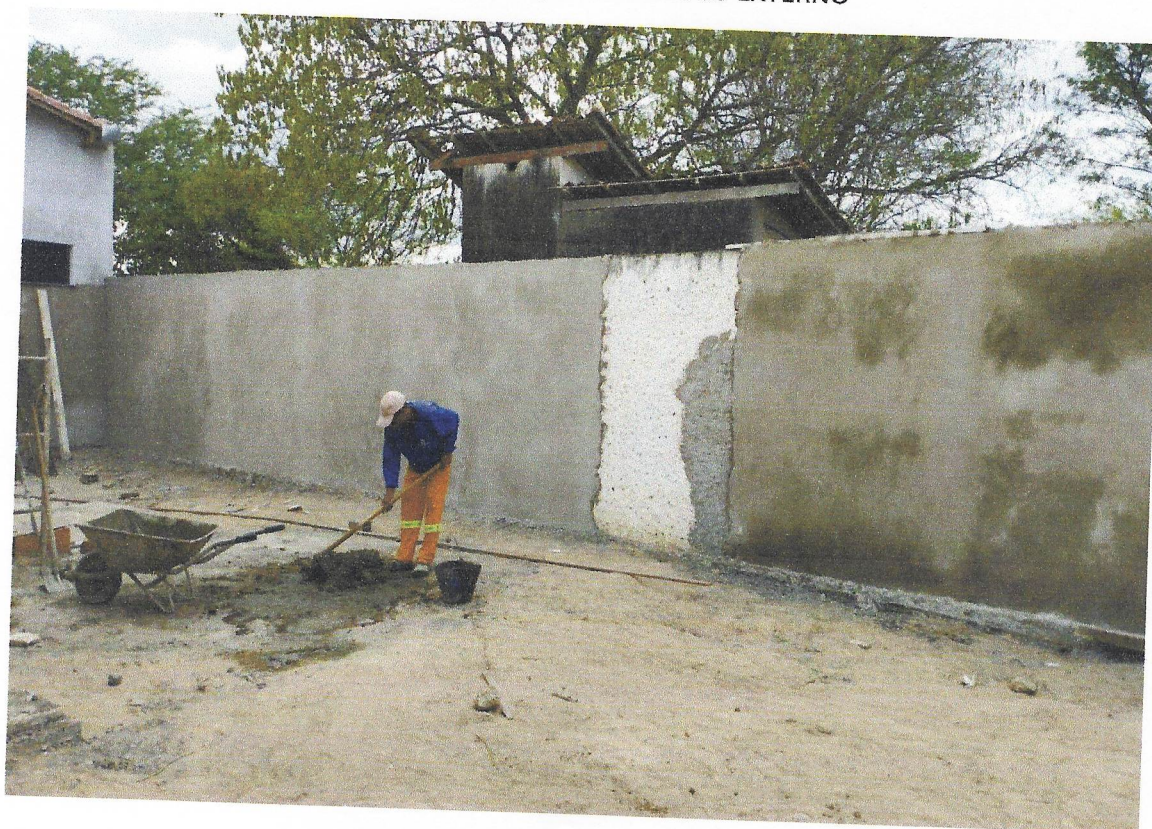
FOTO 08 EXECUÇÃO DE REBOCO EXTERNO
